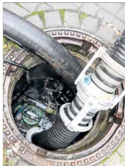
Ab in den Gulli, von hier aus kann das Wasser keinen Schaden mehr anrichten.
