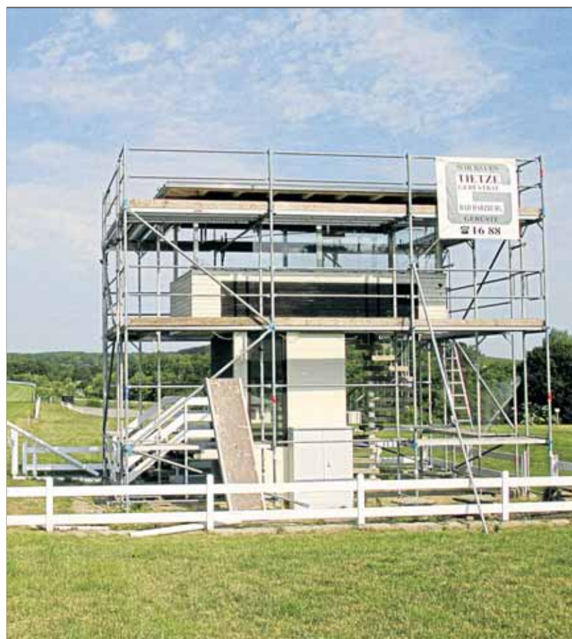
Der Richterturm wird einer Beauty-Kur unterzogen.
