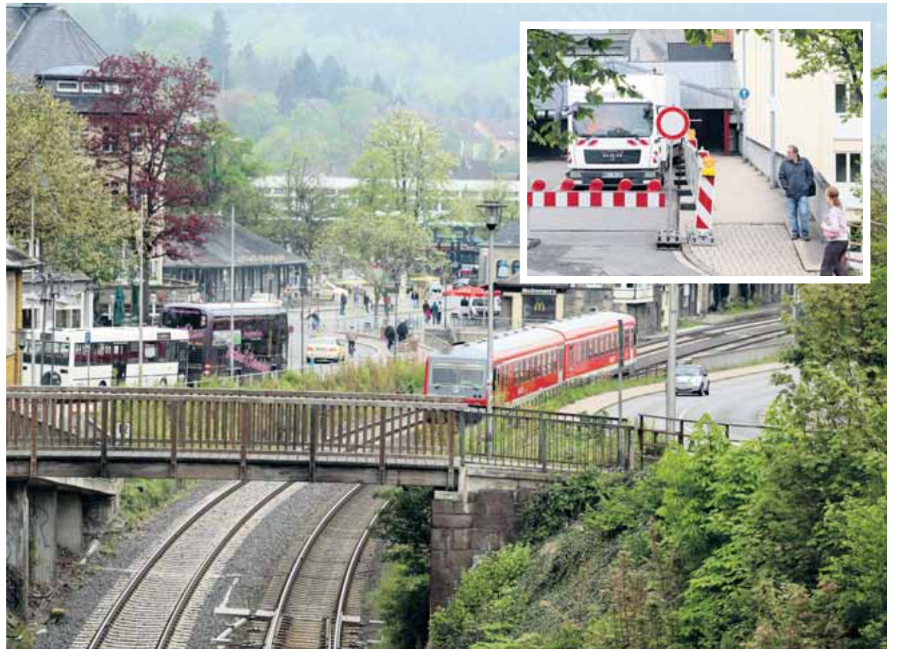
Die Achtermann-Fußgängerbrücke (großes Bild) und die Zufahrt vom Parkhaus werden saniert und müssen deshalb gesperrt werden. Fotos: Kusian-Müller
